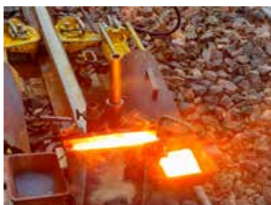
Слика 6.8 Термитна реакција – реакција између алуминијума и гвожђе(III)-оксида
